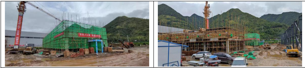
项目地西侧办公区（尚未建成）
