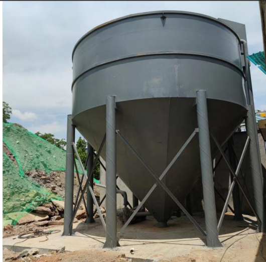
沉淀/浓缩罐已安装，所在废水厂房未建
