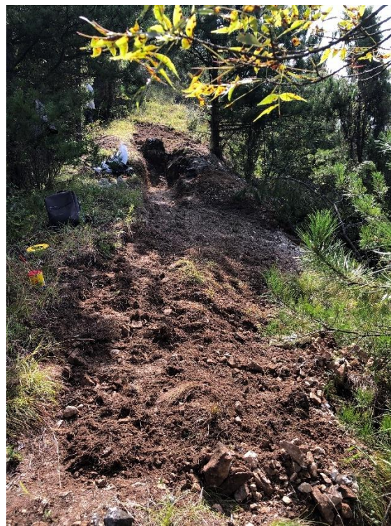
照片 3-2 探槽回填后照片
