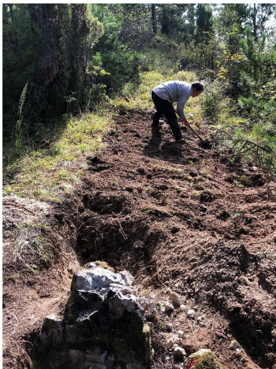
照片 3-1 探槽回填作业
