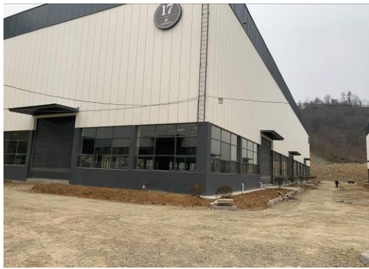
商南县现代材料产业园 17 号厂房
