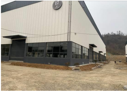
商南县现代材料产业园 17 号厂房
