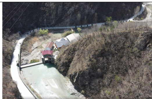
引乾济石取水口2
