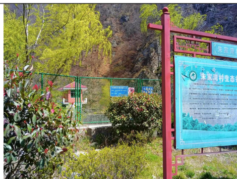
引乾济石取水口1
