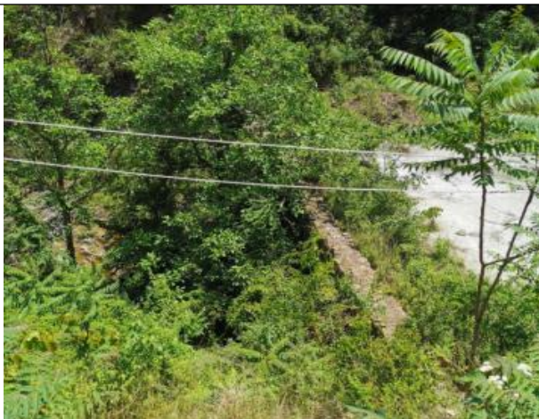
尾矿库上游土石挡体
