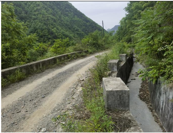
尾矿库西侧挡水墙、道路、雨水渠
