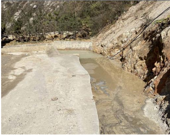
厂区排水沟及沉淀池
