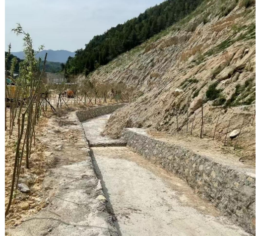
排水沟及生态恢复
